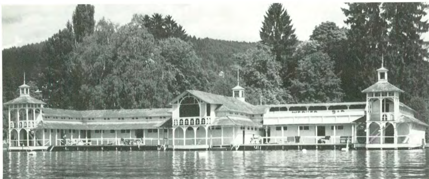
Abbildung 1: Großes Werzer-Badehaus in Pörschach (1894), vom Abbruch bedroht!
