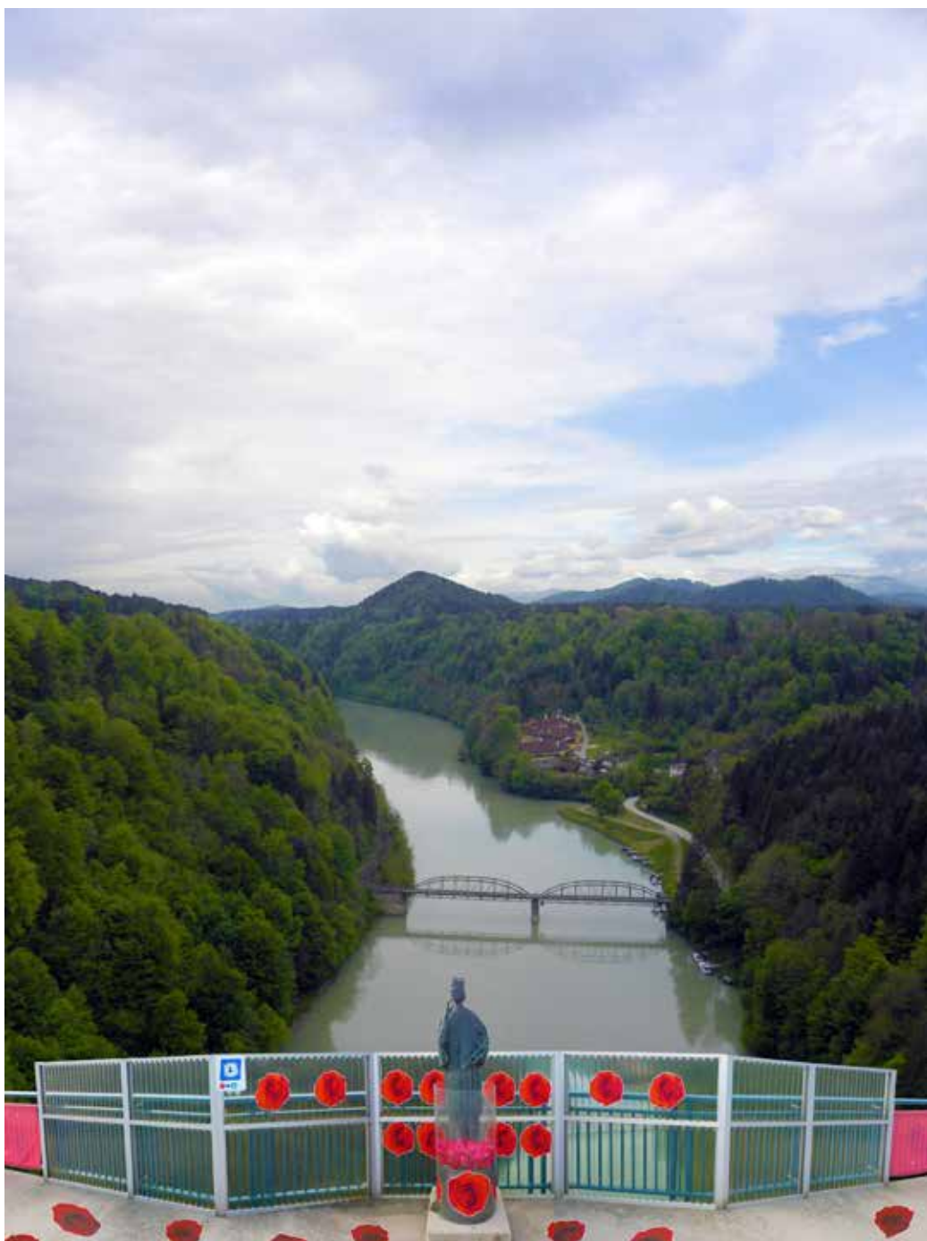
GRADIMO MOSTOVE/BRÜCKEN BAUEN. Fotografija: Gerhard Leeb
