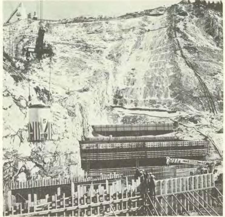
Betonierungsarbeiten an der Kölnbreinsperre.
