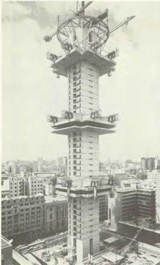
Standard Bank Center, Johannesburg. Baustellenaufnahme
